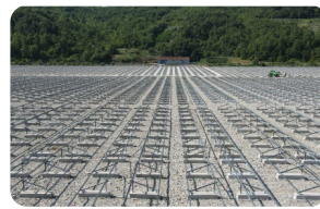
Ndërtimi i strukturave fotovoltaike
