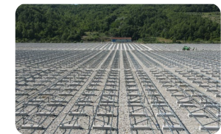
Ndërtimi i strukturave fotovoltaike 2023
